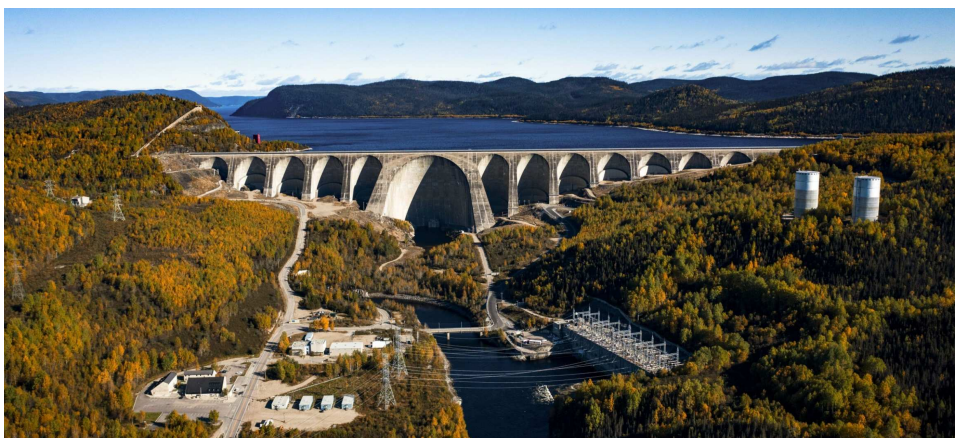
Figure 6.6: Le barrage de la centrale dite Manic-5 (officiellement centrale Daniel-Johnson), sur la rivière Manicouagan (côte Nord). La hauteur de chute est h = 150 m, et le lac-réservoir a un volume V = 136 \times 10^9 \text{ m}^3 lorsque pleinement rempli, couvrant une superficie de 1973 \text{ km}^2 .
