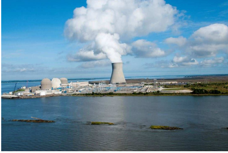
Figure 6.12: Centrale nucléaire de Hope Creek (New Jersey, É.-U.). Les deux réacteurs situés les plus à gauche, plus anciens, utilisent notre option 1, soit siphonner de l'eau de la rivière Delaware pour refroidir le circuit primaire des réacteurs, tandis que le troisième, plus récent, utilise notre option 2, soit refroidir son circuit primaire via la tour d'évaporation au centre de l'image. Le panache blanc émis par la tour est de la vapeur d'eau. Source: blog.ucsusa.org .
