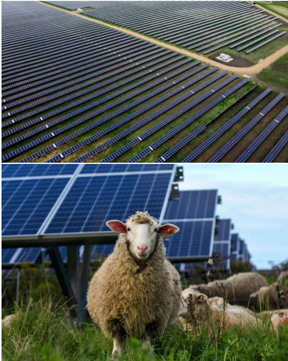
Figure 6.18: En haut: un site de production électrique via panneaux solaires près de Drumheller (Alberta). La perte de terres cultivables peut être évitée en conservant un espacement cultivable entre les rangées de panneaux, et même, dans certains environnements chauds, utiliser l’ombre des panneaux pour protéger les végétaux (ou animaux) du soleil de midi; par exemple en bas: site “agrovoltaïque” près de Ithaca (NY, É.-U.). Source: cbc.ca/news/science/solar-farms-1.7025482 .
