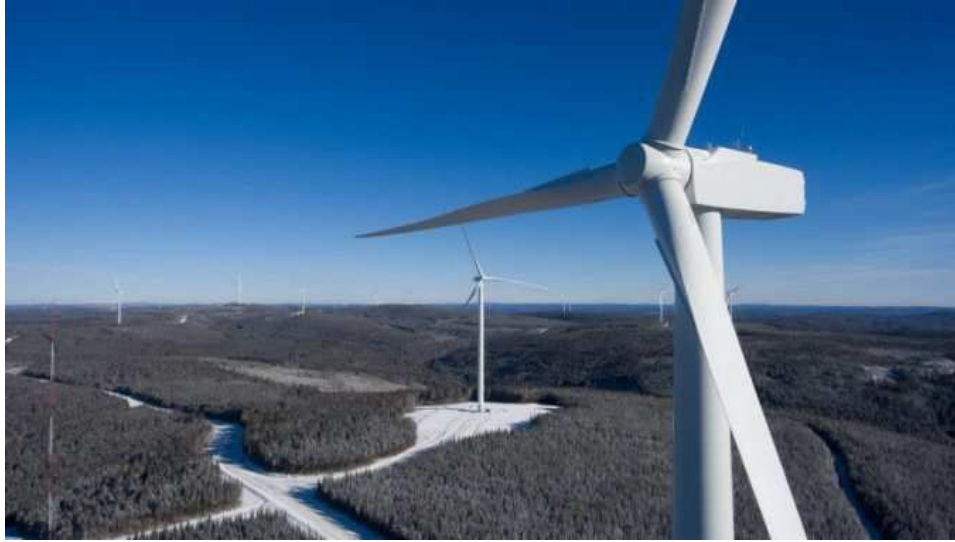
Figure 6.5: Une éolienne contemporaine, ici en Haute-Gaspésie. De tels engins développent typiquement \simeq 5 MW de puissance en continu... tant que le vent souffle. Source: Hydro-Québec.
