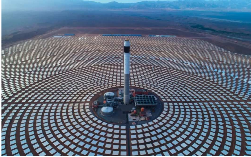
Figure 6.14: Non, ce n'est pas la scène d'ouverture de Blade Runner 2049 , quoiqu'elle en a fort probablement fourni l'inspiration. On voit ici la centrale thermique solaire Noor Ouarzazate III, au Maroc, qui produit 150MW en conditions optimales. Source: http://architectureumaroc.com .
